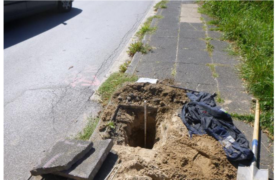
Abb. 57: Nahaufnahme Schurf 1 (Tiefe ~ 60 cm)
